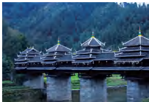
广西三江程阳永济风雨桥
