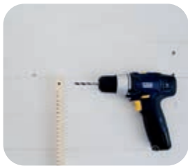
① 用电钻打孔。
