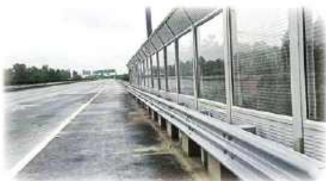
修建隔音设施
