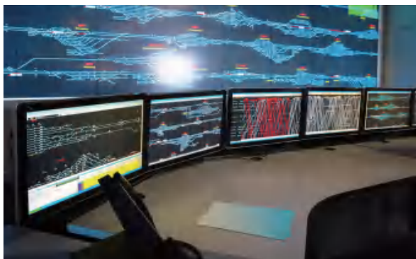
图1-1 高铁控制中心
