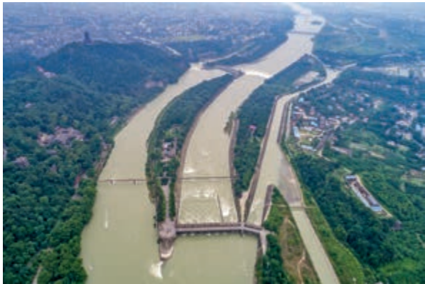
图2.2 都江堰水利工程
