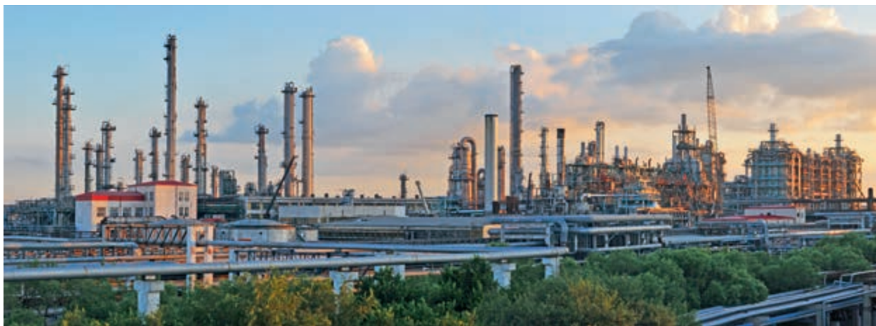
大庆石化公司是我国最早引入乙烯生产的基地之一。图为大庆石化公司联合生产装置。
