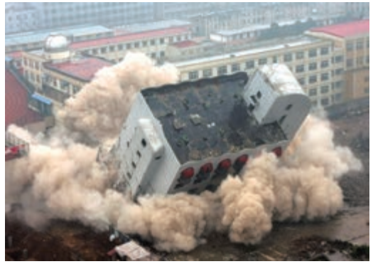
图7-17 利用炸药爆破拆除楼房
