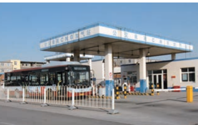
图7-38 压缩天然气汽车加气站
