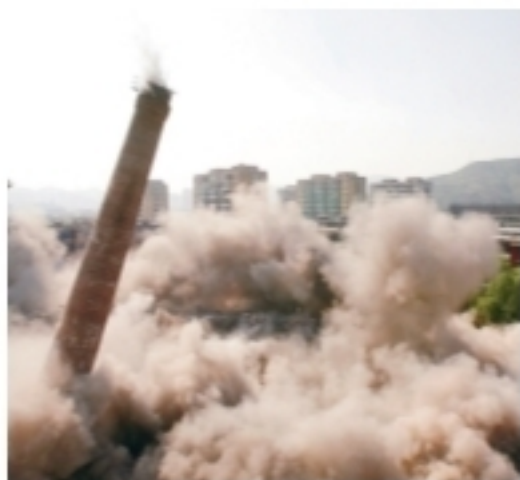
图4-18 拆除污染严重的工厂
