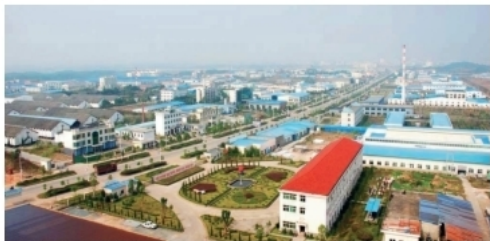
图4-19 新建工业园区
