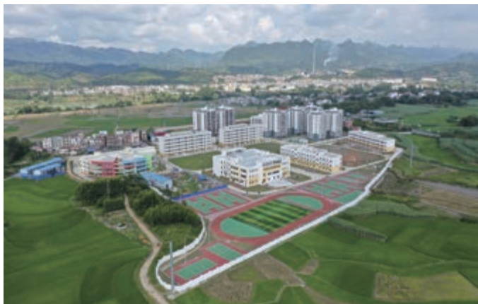
▲ 广西的易地扶贫搬迁安置点
