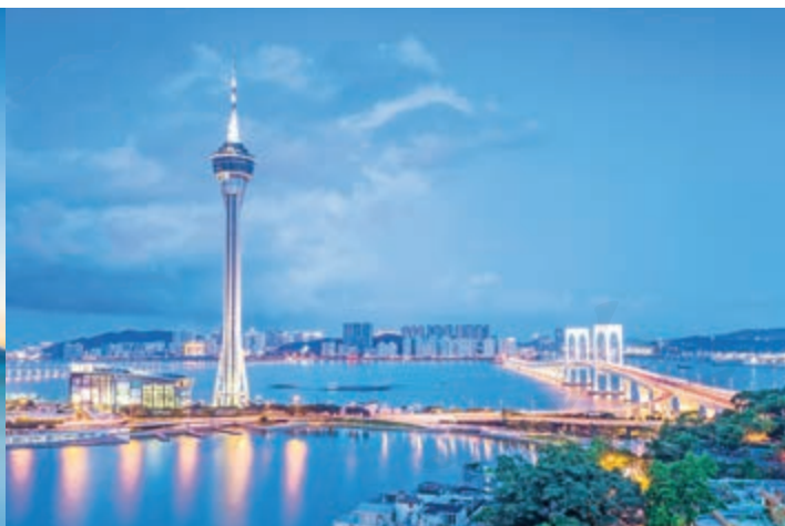
澳门西湾大桥
